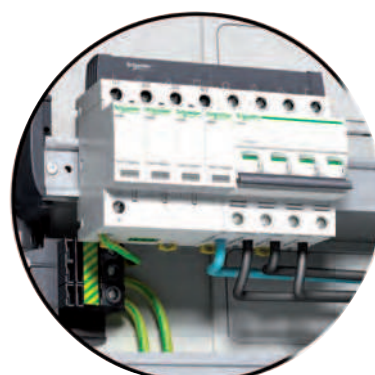
Ogranicznik przepięć 4P + iC60N 4P
