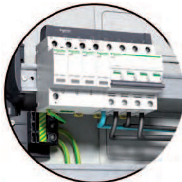
Ogranicznik przepięć iPRD 3P+N + iC60N 3P+N
