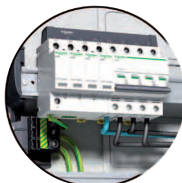
Ogranicznik przepięć 4P + iC60N 4P
